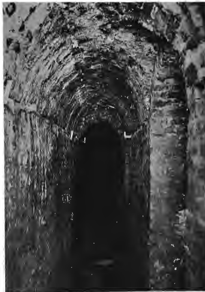
Рис. 39. Тайникъ подъ Алевизовскимъ рвомъ близъ Никольской башни. Направо дверь и два окна въ существовавшую здѣсь палату, теперь разрушенную и засыпанную землей. Прямо — лѣстница въ 4 аршина вышины, выводящая тайникъ изъ подъ рва. (Съ фот. кн. Н. С. Щербатова).
