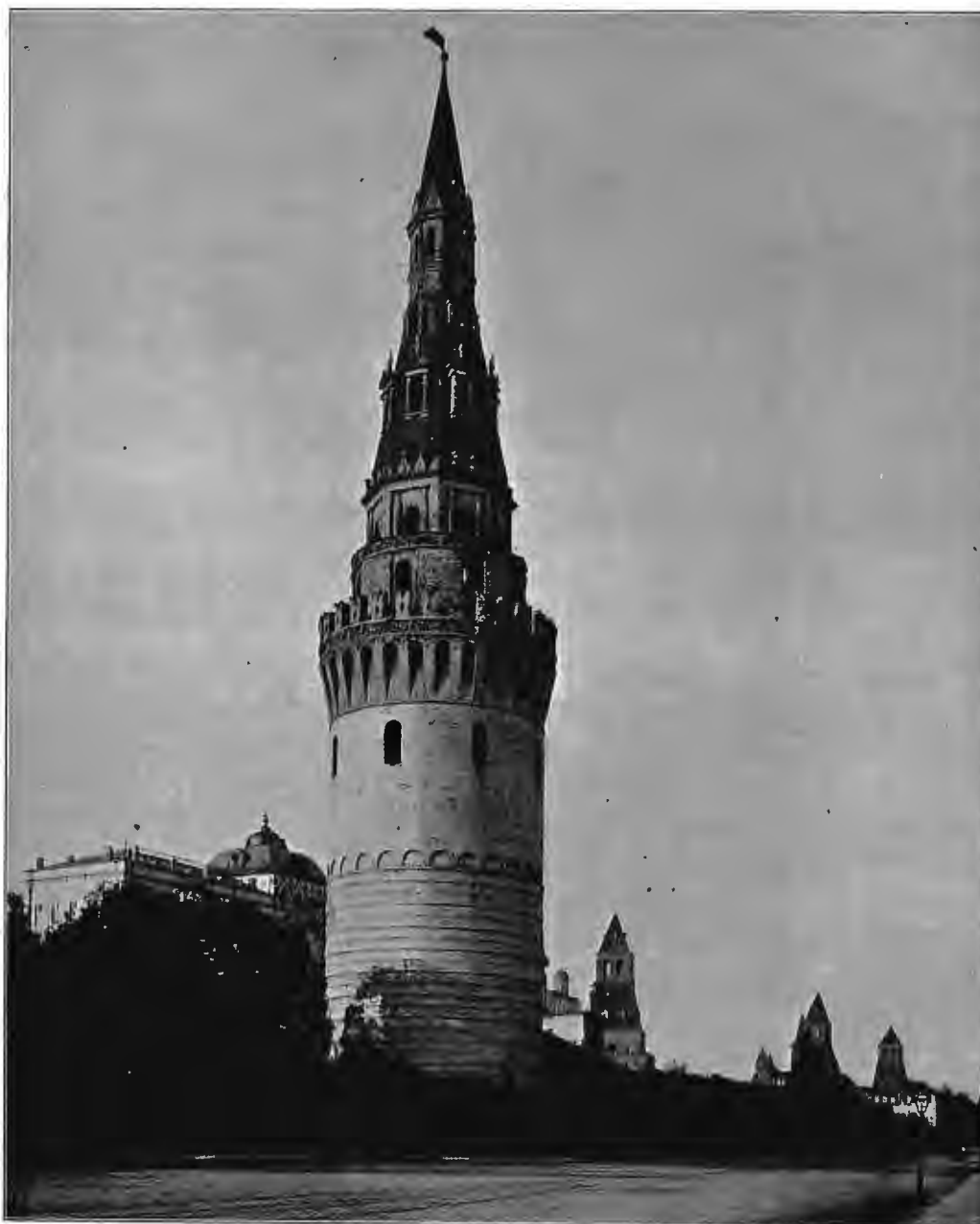
Рис. 249. Водовзводная башня. За нею видны слѣва Большой Кремлевскій Дворецъ, справа башни: Благовѣщенская, Тайницкая, 1 Безымянная.
