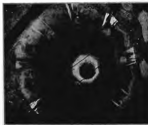
Рис. 248. Беклемишевская башня. Сводъ верушки.
