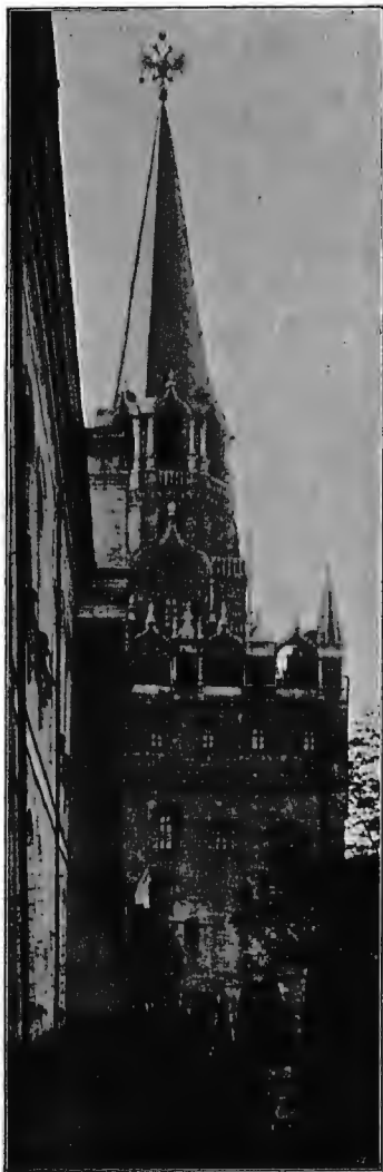
Рис. 101. Дымоходъ электрической станціи близъ Троицкой башни.
