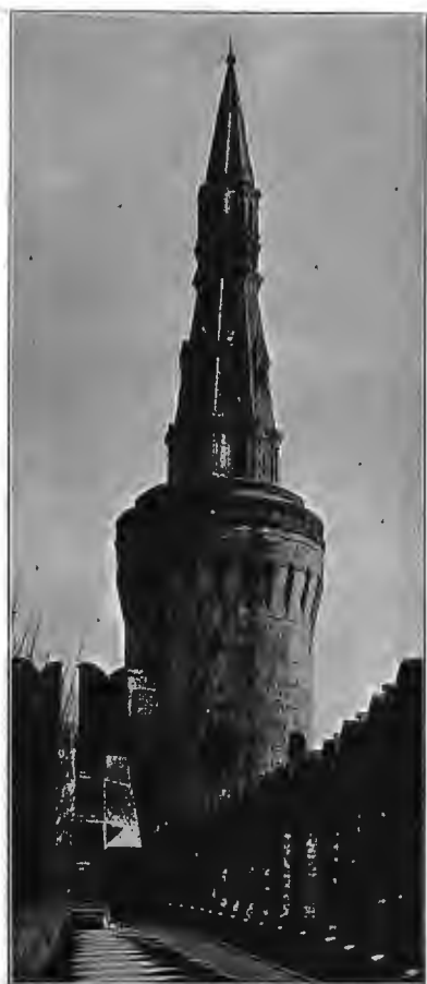
Рис. 237. Беклемишевская башня. Видъ со стѣны, съ западной стороны.
