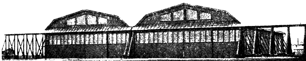
Деревянный двухсечечный ангар.
